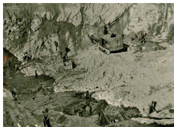
Baustelle der Vorarlberger Illwerke in der Silvretta (Quelle: VLB)
